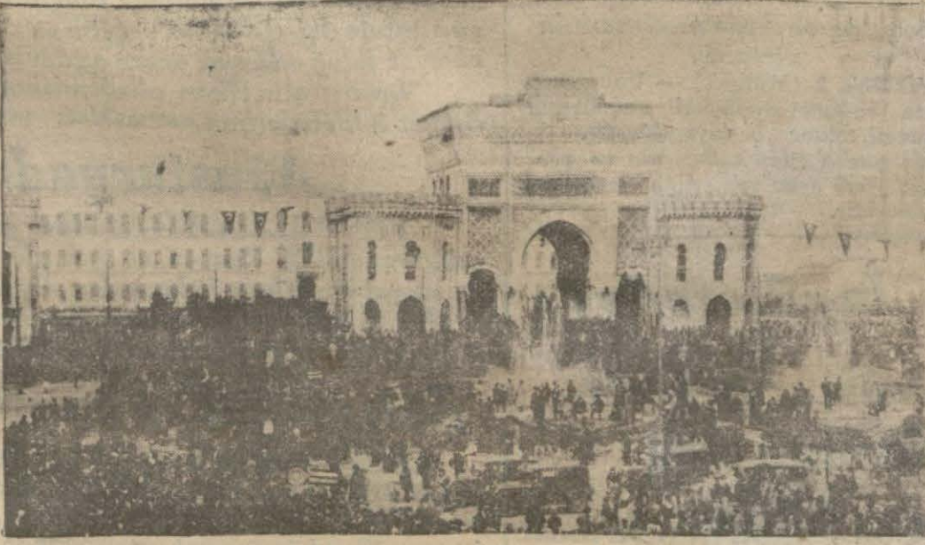
Istanbul Üniversitesi binası..
