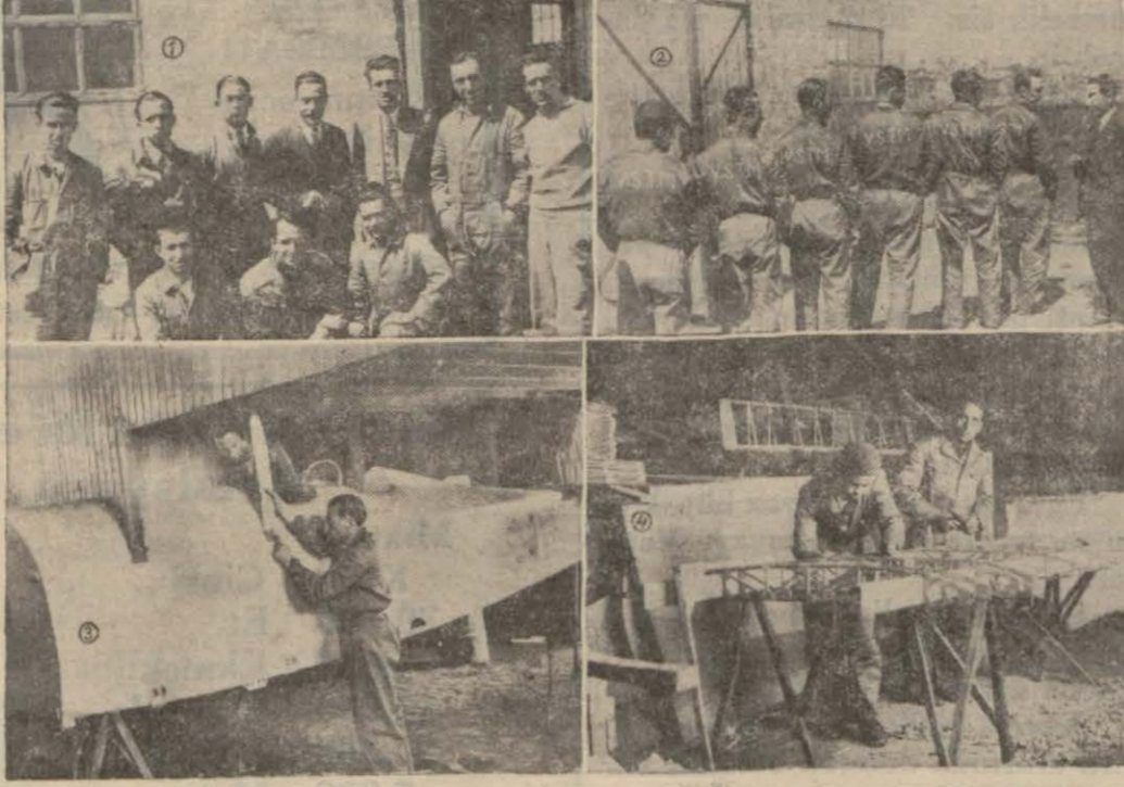
1. ve 2. Vecihi Bey talebeleri bir arada 3. — Vecihi Bey mektebinin, Kızıltopraktaki hangarında inşa edilmekte olan yeni bir tayyare. 4. — Tayyarenin kanatları çakılırken.
