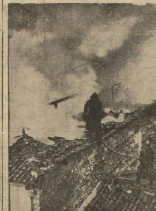
İtfaiye Tahtakaledeki yangını söndürmeğe çalışıyor.
