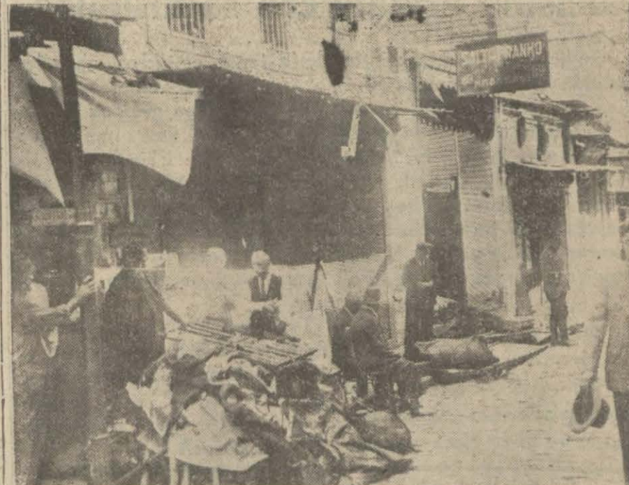
Yangından sonra Fincancılar yokuşunun hali..
