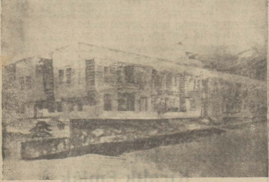
Ankarada yeni yapılacak olan Divanı muhasebat binasının cepheden görüldüğü
