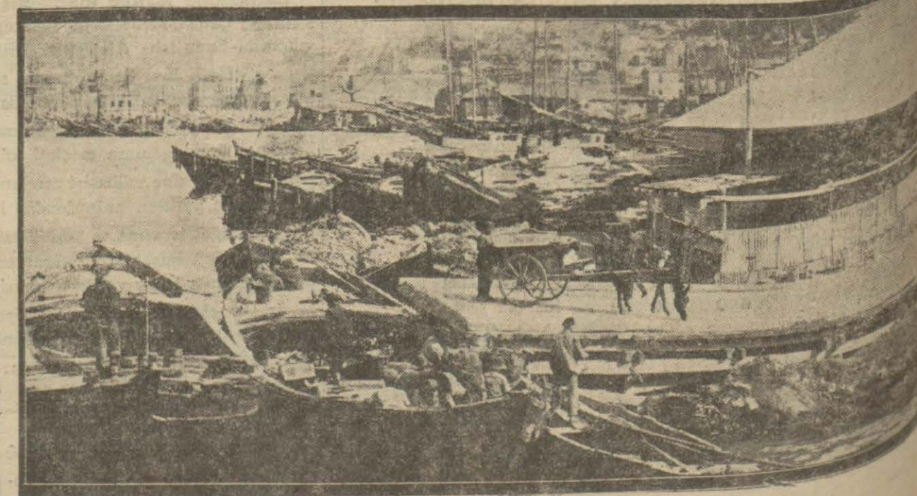
Şehremaneti çöplerin mavnalar vasıtası ile denize dökülmesi için uında bir iskele yaptırmıştır
