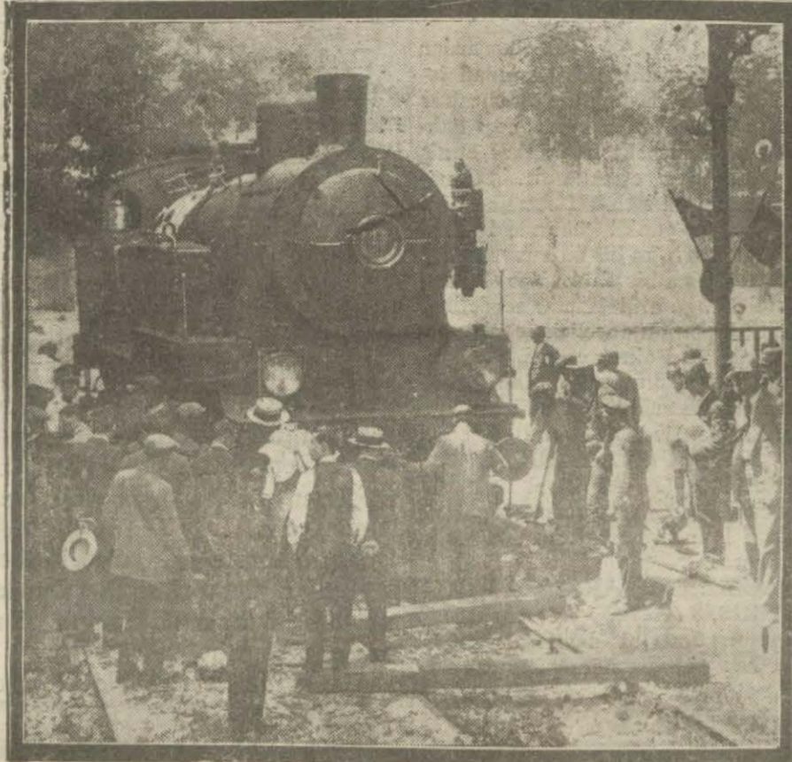
400 Yolcunun hayatını tehlikeye sokan ve ta dış havluya kadar çıkan lokomotifi yerine götürmek için çalışıyorlar!
